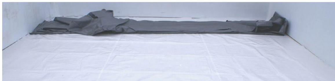
Figure 32 – Dépliage du liner
