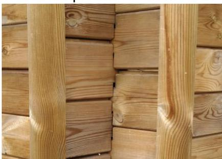
Monter un profil de finition à chacune des extrémités des parois. Pour ce faire, utiliser 3 pointes à tête bombée de 2.8 x 60 : une en haut, une au milieu et une en bas de chaque extrémité. Faire en sorte que les pointes soient au centre des lames de paroi pour éviter leur éclatement.
