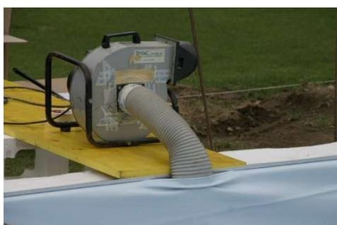
Avant de commencer l'aspiration, vérifiez que toutes les vannes du système de circulation d'eau soient complètement fermées. Par conséquent, allumer l'aspirateur correctement relié au tube, de sorte que son action crée un vide entre les deux surfaces.
