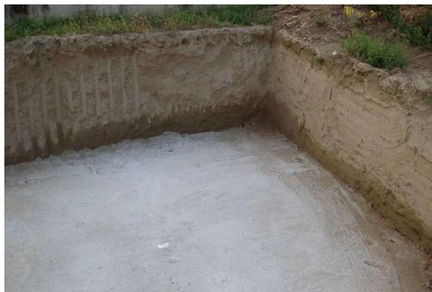
Il est recommandé d'utiliser un béton de bonne consistance (classe S3-S4) afin de faciliter les opérations et sa distribution. Pour le nivellement du béton, il est recommandé d'utiliser une règle, dans l'ordre suivant : la partie plate, les parois en pente de tronc de pyramide et en dernier lieu le fond de la fosse à plonger (déjà en partie remplie du béton en surplus). Une fois que tout le béton est tiré, procéder avec le lissage.
